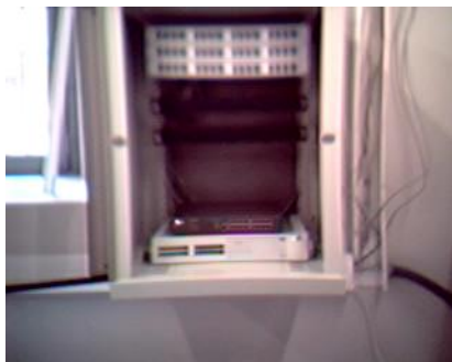
Armario de comunicaciones. Frontal y bastidor de conexiones.
